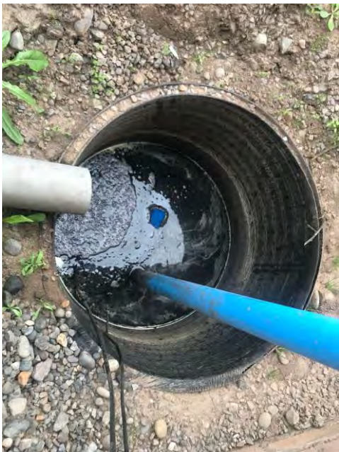
Imagen 1: Colector de percolados de la cancha de secado.
