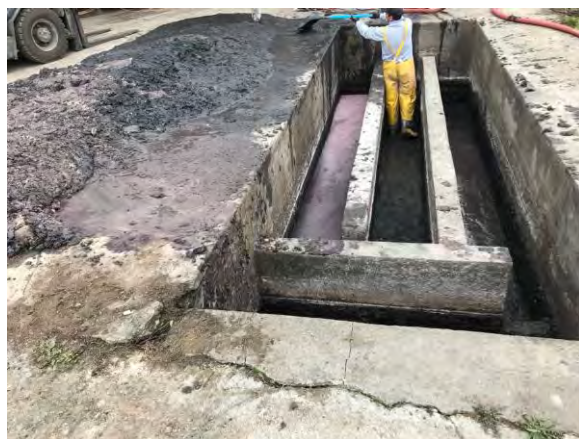
Imagen 4: Limpieza pozo decantador
